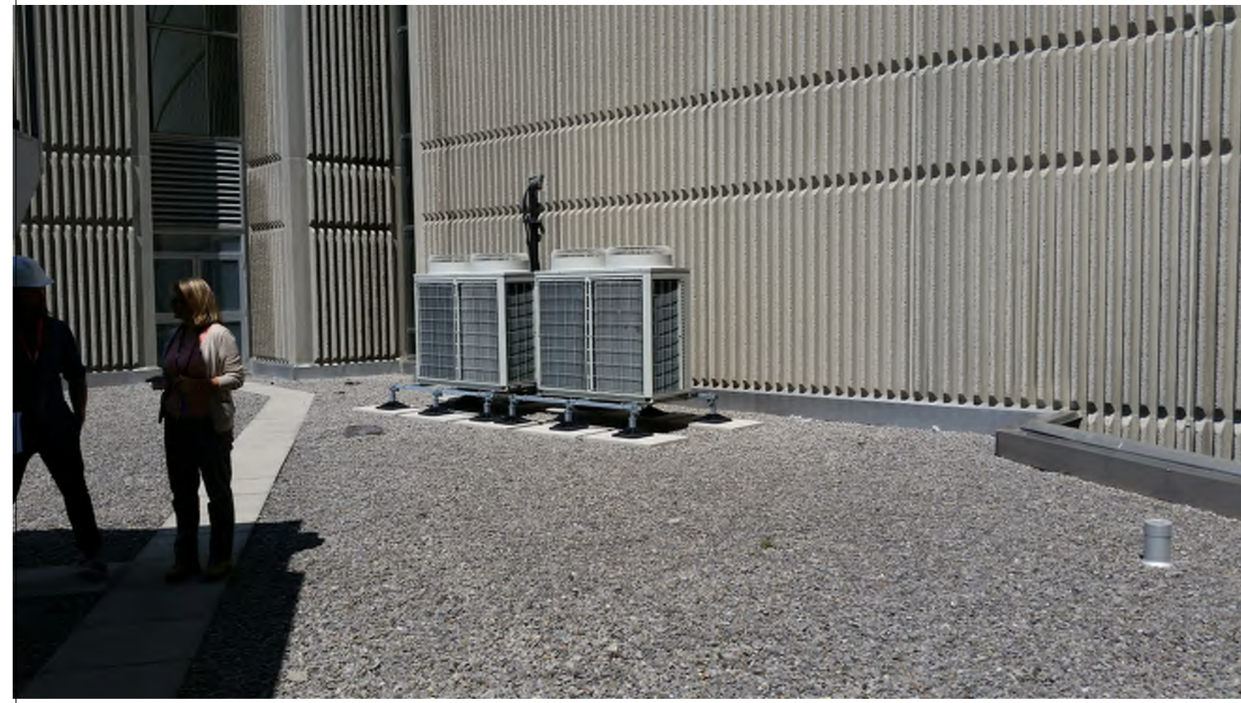
6 OPG EXTERIOR PHOTOGRAPH A80-00-01 N.T.S.
