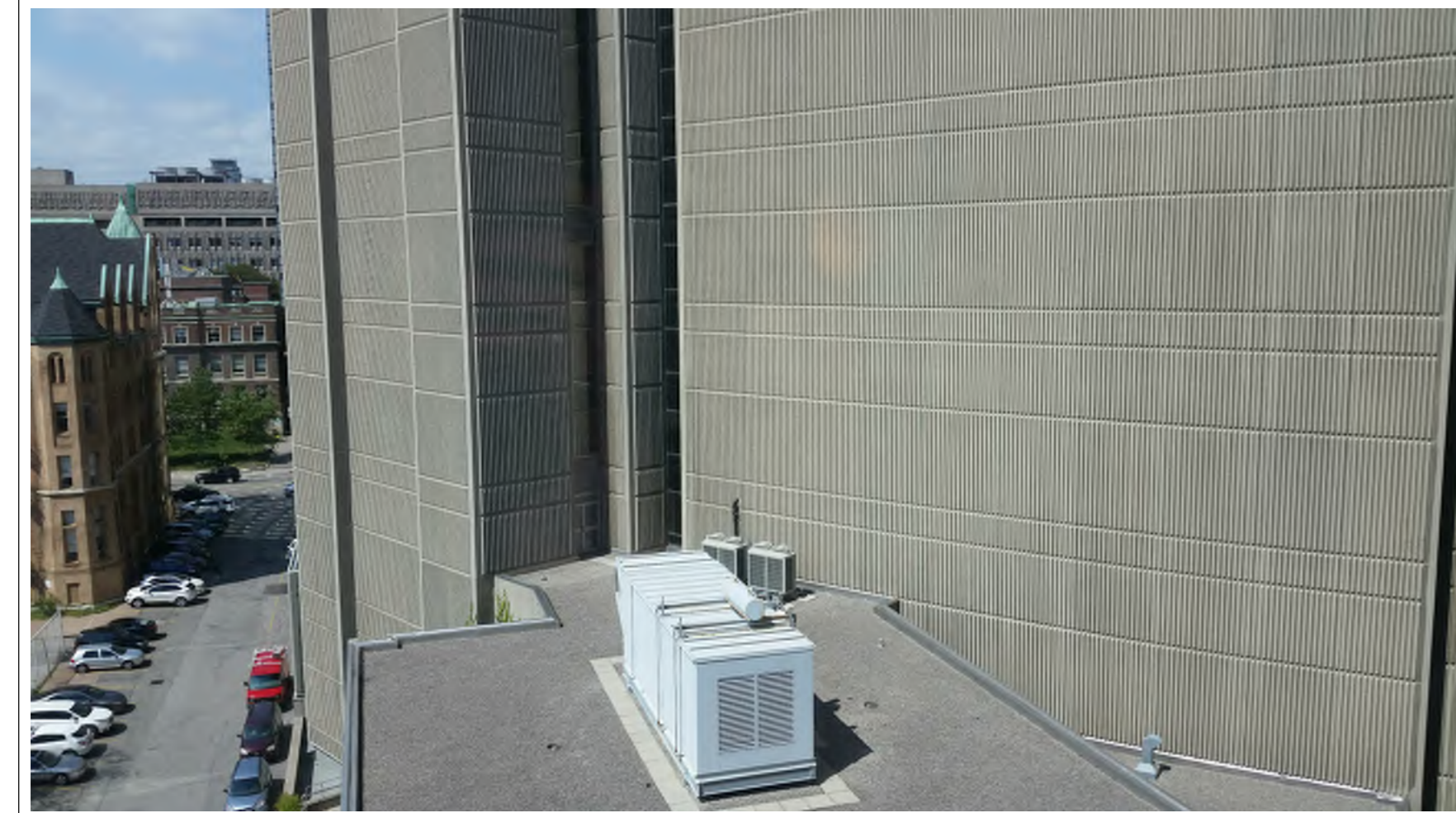
5 OPG EXTERIOR PHOTOGRAPH A80-00-01 N.T.S.
