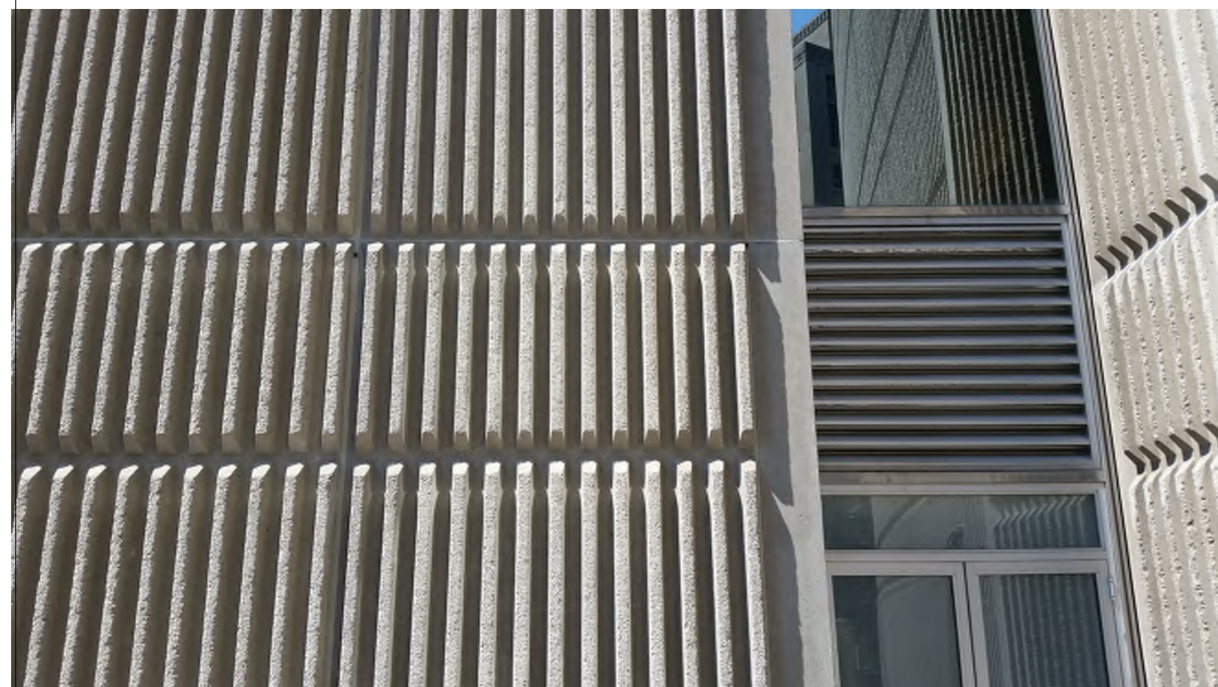
5 OPG EXTERIOR PHOTOGRAPH A80-00-01 N.T.S.
